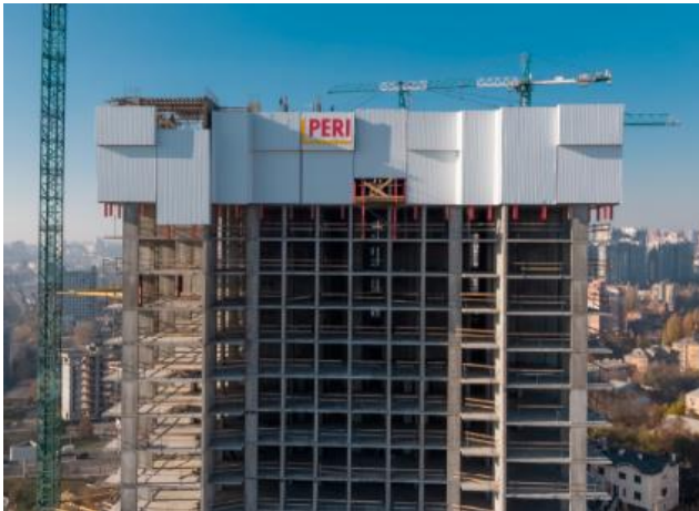
Рисунок 1. Загальний вигляд захисного екрану за технологією рейкової підйому PERI RCS P
