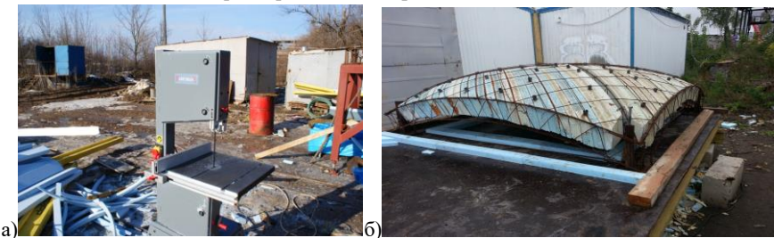
Рис. 1. Изготовление вкладышей несъемной опалубки: а) станок для вырезания элементов вкладышей; б) вкладыши, установленные в самонесущий остов
