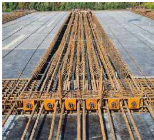
Рисунок 2. Попередньо напружена монолітна залізобетонна балка (Будівництво школи в м. Києві)
