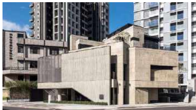
Рисунок 4. Загальний вигляд будівлі.
