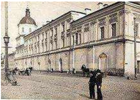
Рис.1 Оригінальний вигляд фасаду Староакадемічного корпусу наУКМА
