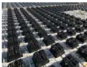
Рисунок 4. Принцип влаштування перекриття з точковими пустоутворювачами
