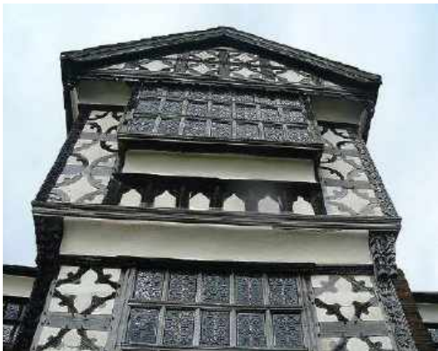
Рисунок 4. Елементи фахверкового каркасу
