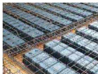
Рисунок 3. Принцип влаштування перекриття з лінійними пустотоутворювачами
