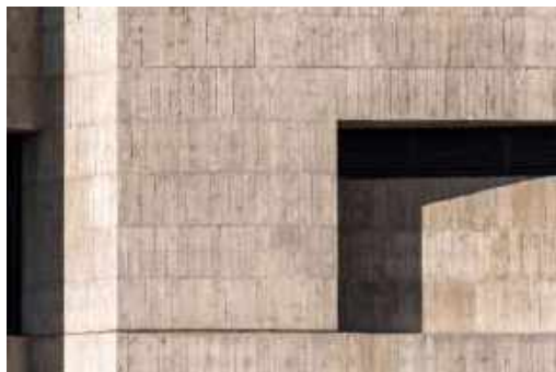
Рисунок 1. Sharing Space Building Near Taipei. Елемент фасаду.
