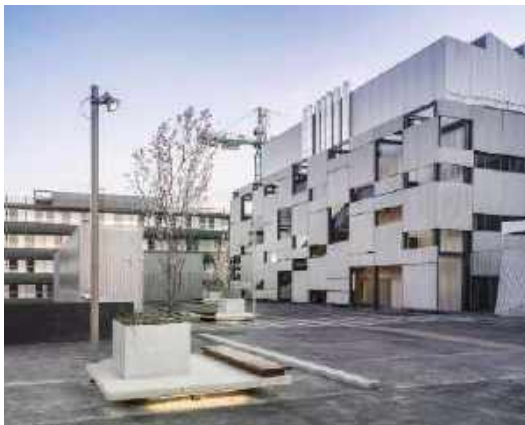
Рис. 4. Фасадні рішення університетської лікарні
