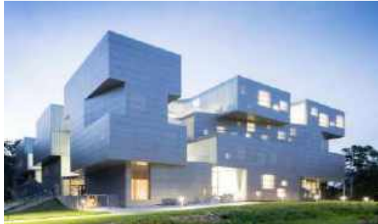
Рисунок 4. Приклади блочних споруд: а - Токіо. Район Міната. Капсульна башта «Накагін»; б – Нью-Йорк. Новий
