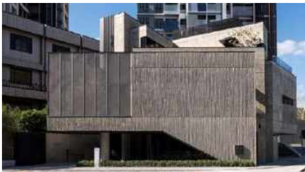
Рисунок 3. Sharing Space Building Near Taipei. Південний фасад.
