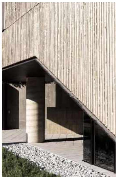
Рисунок 2. Sharing Space Building Near Taipei. Елемент фасаду
