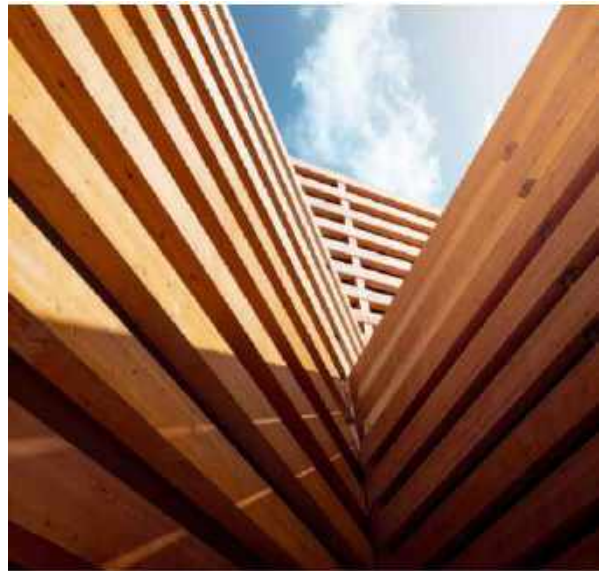
Рисунок 4. Зовнішнє облицювання будівлі деревиною
