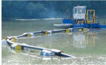
Рис. 2. Робота земснаряда в акваторії Сабаріського водосховища
