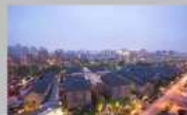
Готель Cheery canal м.Ханчжоу реконструкція у 2015 р.
