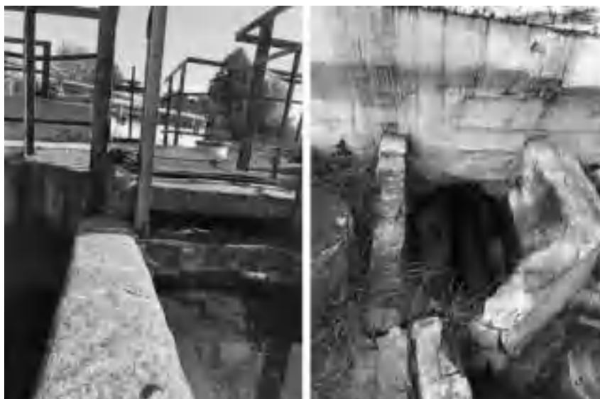
Рис. 1. Стан будівельних конструкцій діючих міських очисних споруд
