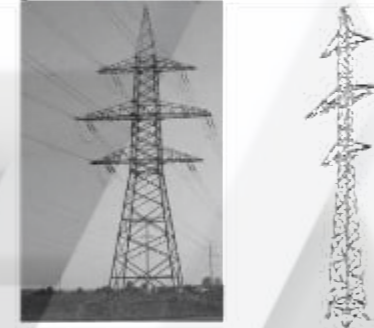
ОПОРИ ДЛЯ ЛЕП, ОСВІТЛЕННЯ
