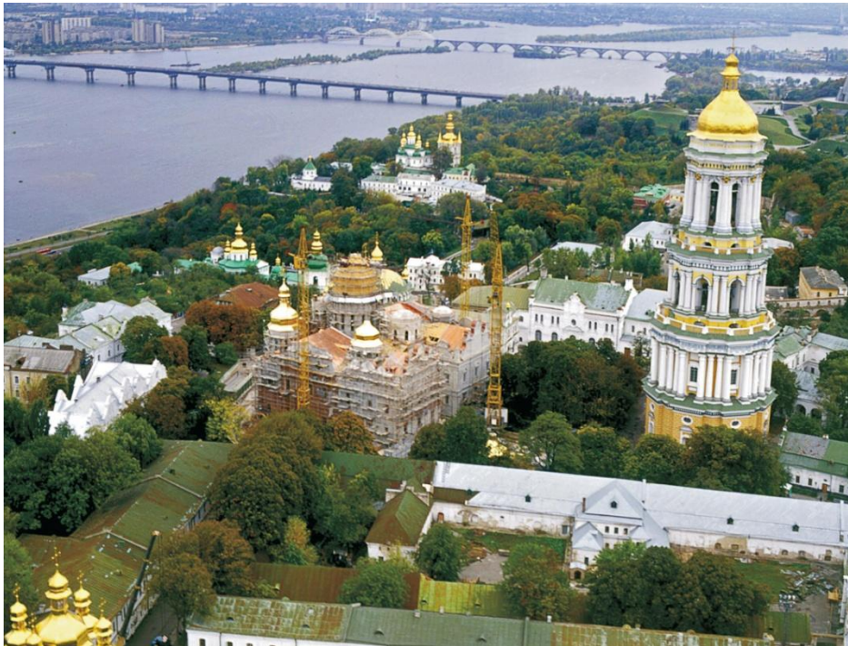
Рис.2. Завершальні етапи відтворення. Влаштування покрівлі та бань Успенського собору
