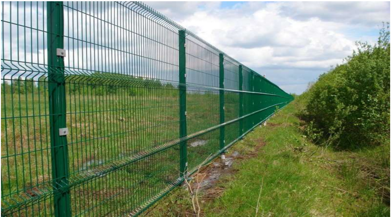
Рис 5.4 Загальний вигляд системи огороження секційного типу
