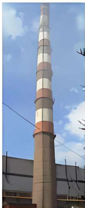
• Залізобетонна димова труба
