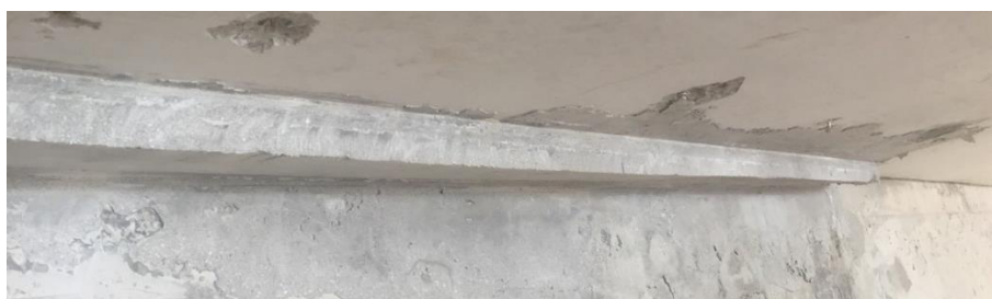
Рис. 4.15. Загальний вигляд відновленої частини дна басейну
