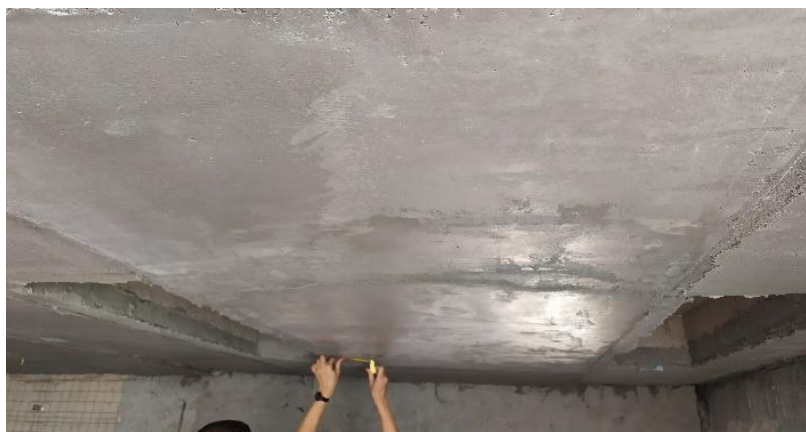
Рис. 4.16. Відновлена плита перекриття підземного переходу
