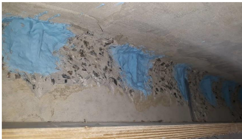
Рис. 4.13. Щілина басейну підготовлена до ремонту
