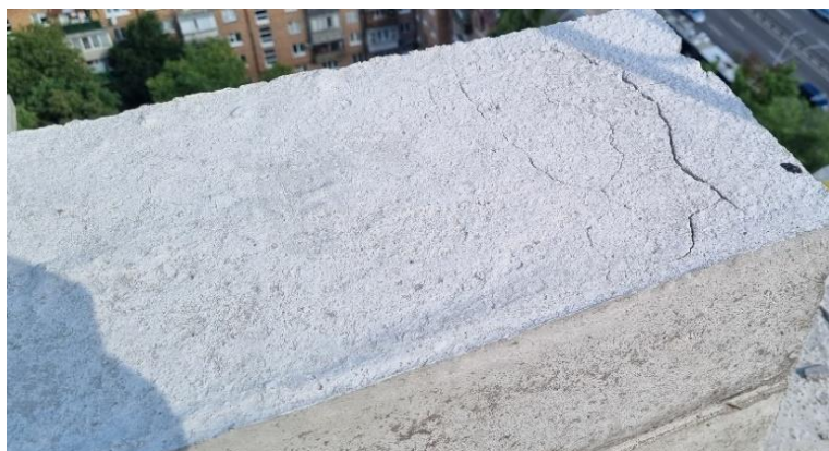
Рис. 1.9. Результат впливу пластичної усадки бетону
