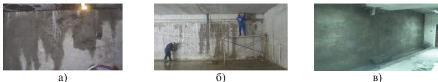
Рис.1. - Технологія нанесення гідроізоляційного розчину: а) вихідна конструкція; б) процес нанесення покриття; в) відновлена поверхня конструкції
