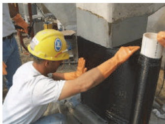
Рис. 2. Фрагмент виконання робіт з підсилення колон вуглеволокном
