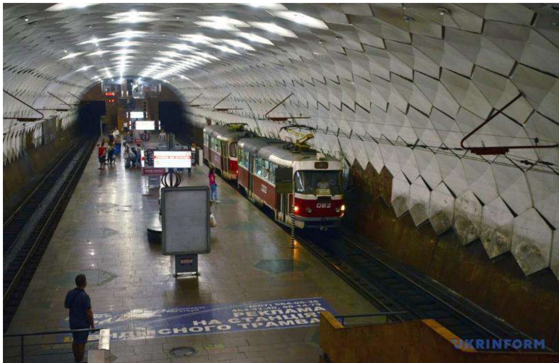
Рис 3.3. Підземна станція криворізького швидкісного трамваю
