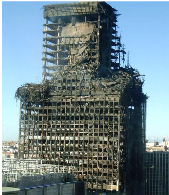
Рис 1.15. Наслідки прогресуючого руйнування багатоповерхової будівлі зі сталевим каркасом від пожежі в Мадриді в 2005 р.
