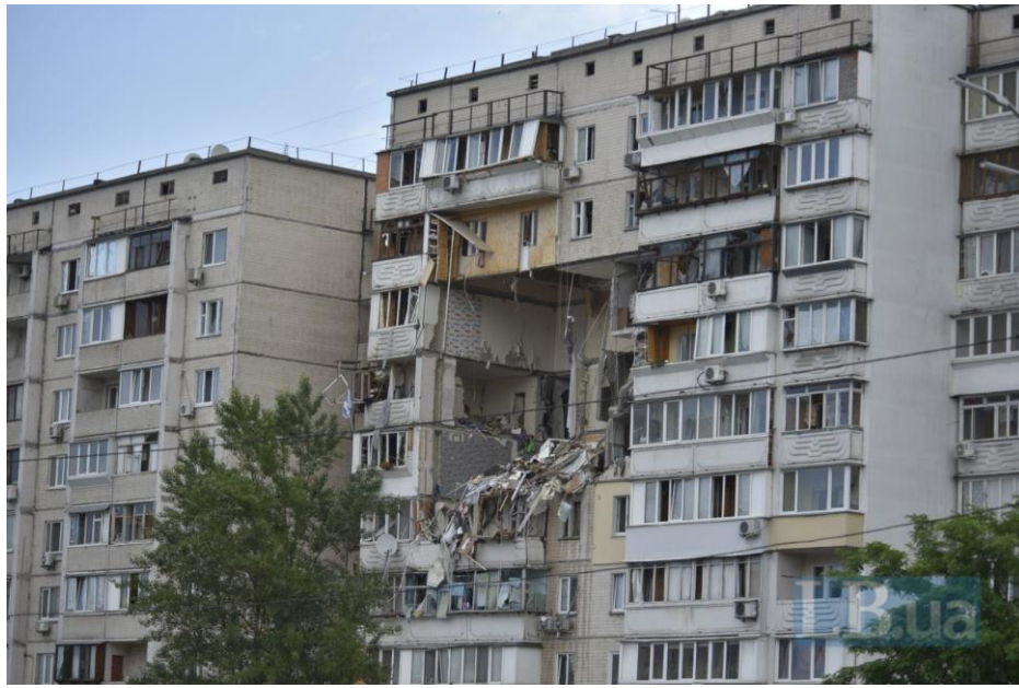
Рис.1.2. Пошкодження житлового будинку в Києві внаслідок вибуху газу 2020р.
