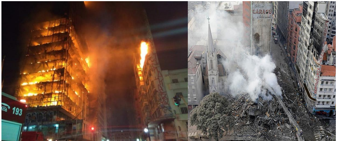
Рис 1.14. Наслідки прогресуючого руйнування багатоповерхової будівлі зі сталевим каркасом від пожежі в Сан-Паулу в 2018 р.
