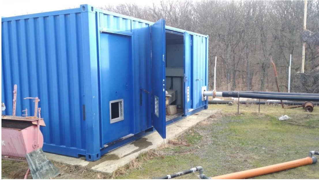
Рисунок 2. Електростанція контейнерного типу, що працює на звалищному газу
