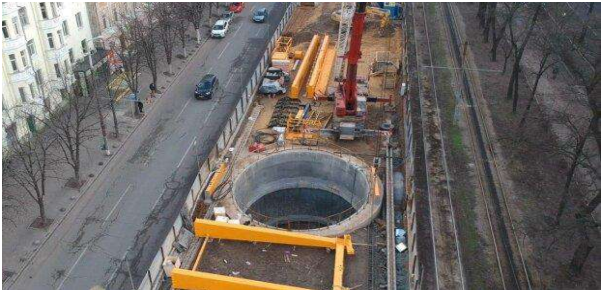
Рис. 1.7. Будівництво продовження дніпровського метрополітену
