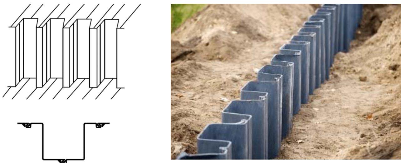
Рис.1.3. Шпунтова конструкція огороження котловану
