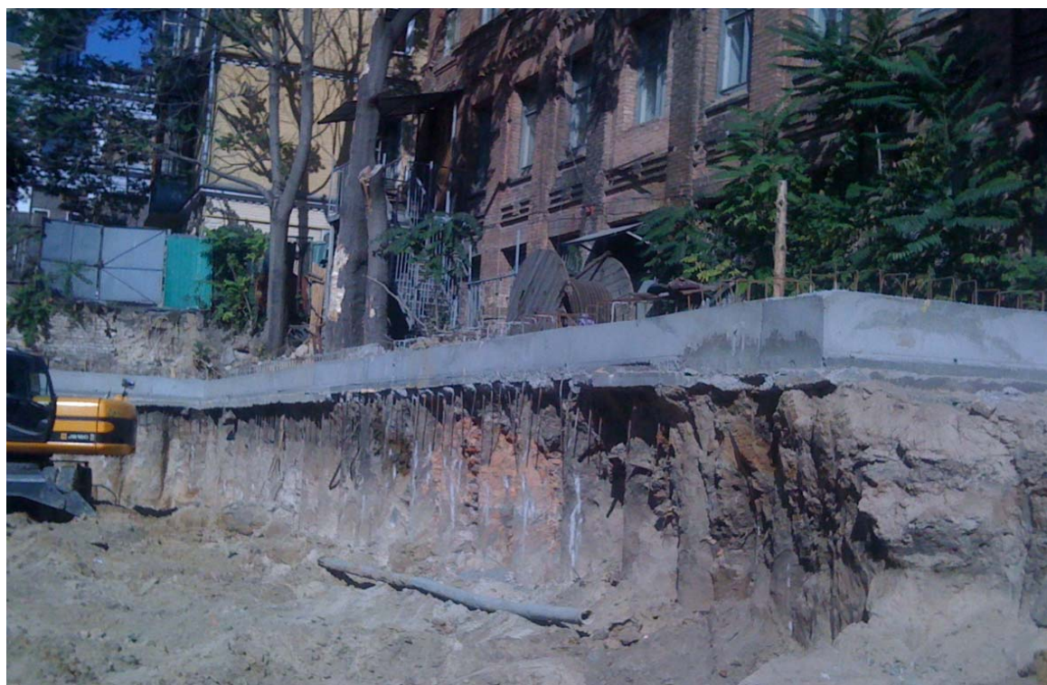
Рис.5.4. Початковий етап відкопування котловану із попередньо влаштованими: захисним екраном та огороженням котловану
