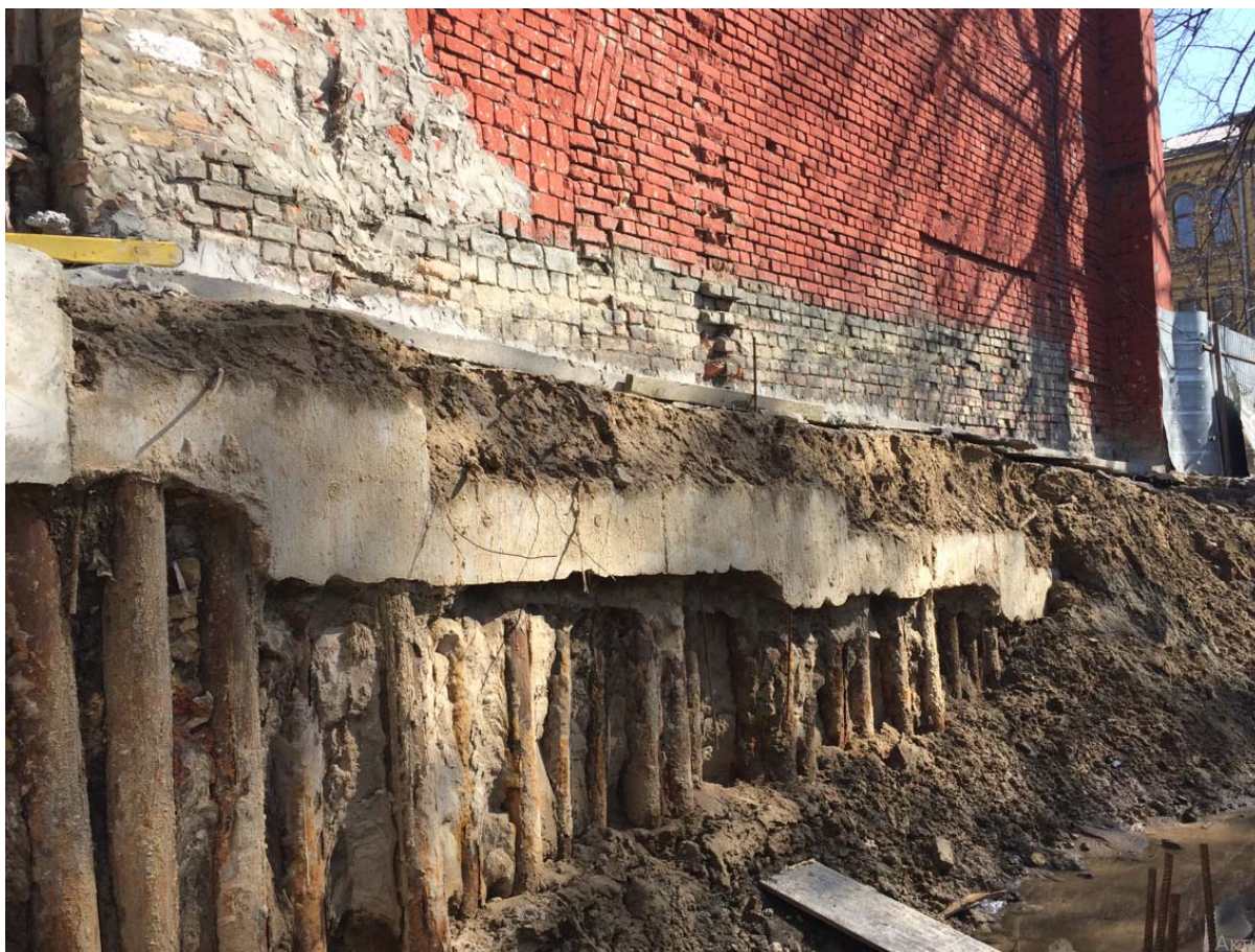
Рис.5.3. Конструкція влаштованого захисного екрану із труб в торці існуючої будівлі
