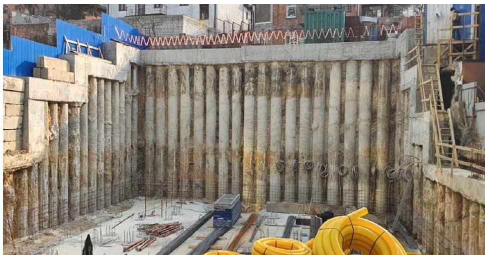
Рис. 1.4. Огороження котловану із буронабивних палей
