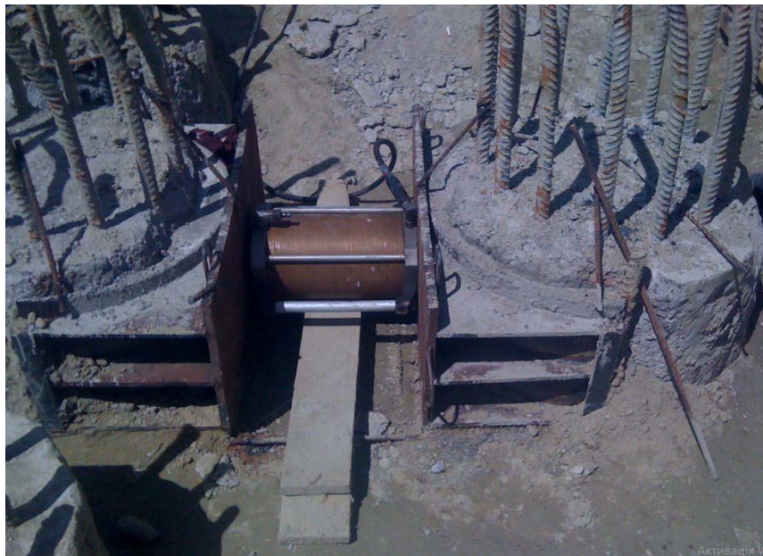
Рис.2.16. Дослідне устаткування для випробування на горизонтальне навантаження.
