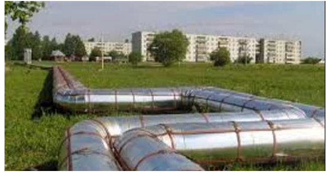
Рис.4.8 – 4.9 Компенсатори температурного видовження
