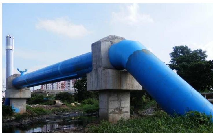
Рис.4.7 Перехід над перешкодою магістрального трубопроводу
