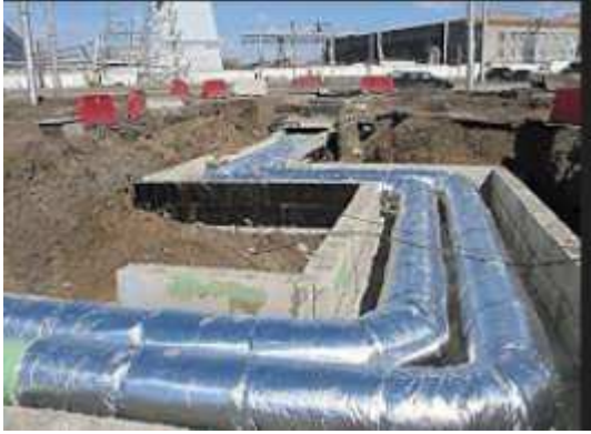
Рис.4.8 – 4.9 Компенсатори температурного видовження
