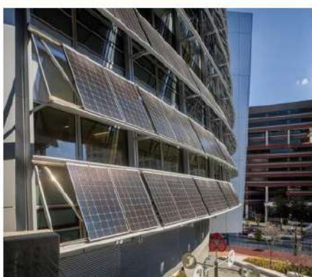
ВИКОРИСТАННЯ ГЕЛІОКОЛЕКТОРІВ В ЯКОСТІ СОНЦЕЗАХИСНИХ ПАНЕЛІЙ
