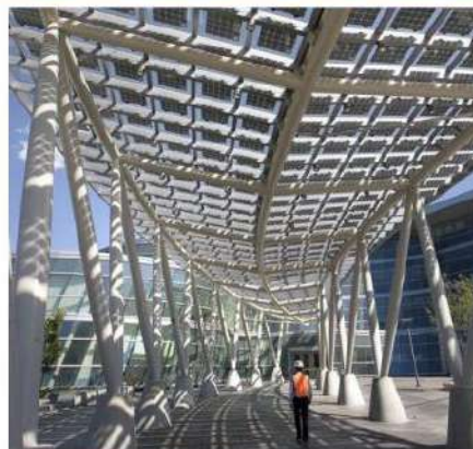
ВИКОРИСТАННЯ ГЕЛІОКОЛЕКТОРІВ В ЯКОСТІ ПЕРГОЛ- ПЕРЕХОДІВ ТА ПЕРГОЛ-ТОРГОВИХ РЯДІВ В МЕЖАХ ТРЦ
