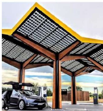
ЗАРЯДНІ СТАНЦІЇ ВІД ГЕЛІОКОЛЕКТОРІВ НА ПАРКУВАЛЬНИХ МАЙДАНЧИКАХ ТРЦ
