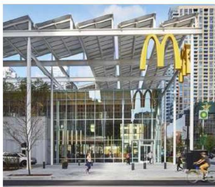
ГЕЛІОКОЛЕКТОРИ НА ПОКРІВЛІ В ЯКОСТІ СОНЦЕЗАХИСНИХ ПАНЕЛІЙ
