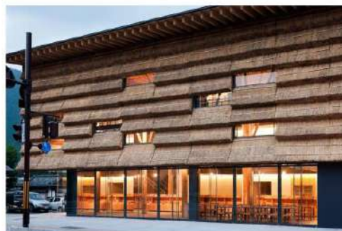
Солом'яний фасад в Японії. Архітектор Юсухара Марке / фото Architizer
