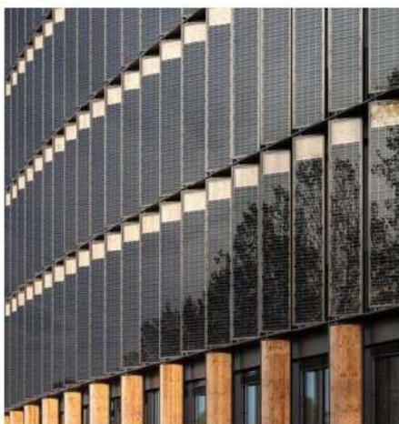
ВИКОРИСТАННЯ ГЕЛІОКОЛЕКТОРІВ В ЯКОСТІ СОНЦЕЗАХИСНИХ ПАНЕЛІЙ
