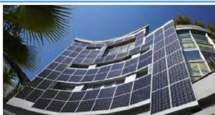
ВИКОРИСТАННЯ ГЕЛІОКОЛЕКТОРІВ В ЯКОСТІ СОНЦЕЗАХИСНИХ ПАНЕЛІЙ
