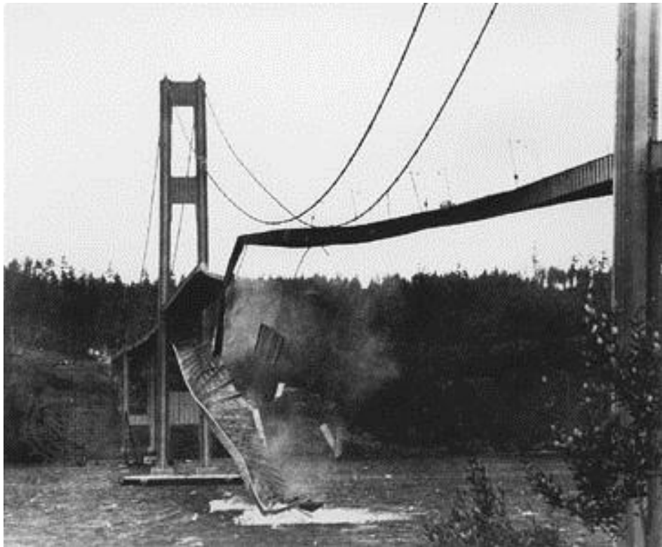
Рис. 1.3 Падіння Такомського мосту внаслідок флатеру прольотної споруди 7 листопада 1940р.
