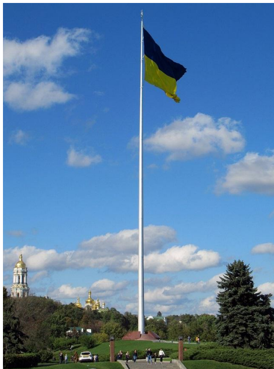
Рис. 2.2.5 Флагшток висотою 89,2 м у Києві під прапор розмірами 16х24м, встановлений до 22 серпня 2020 р
