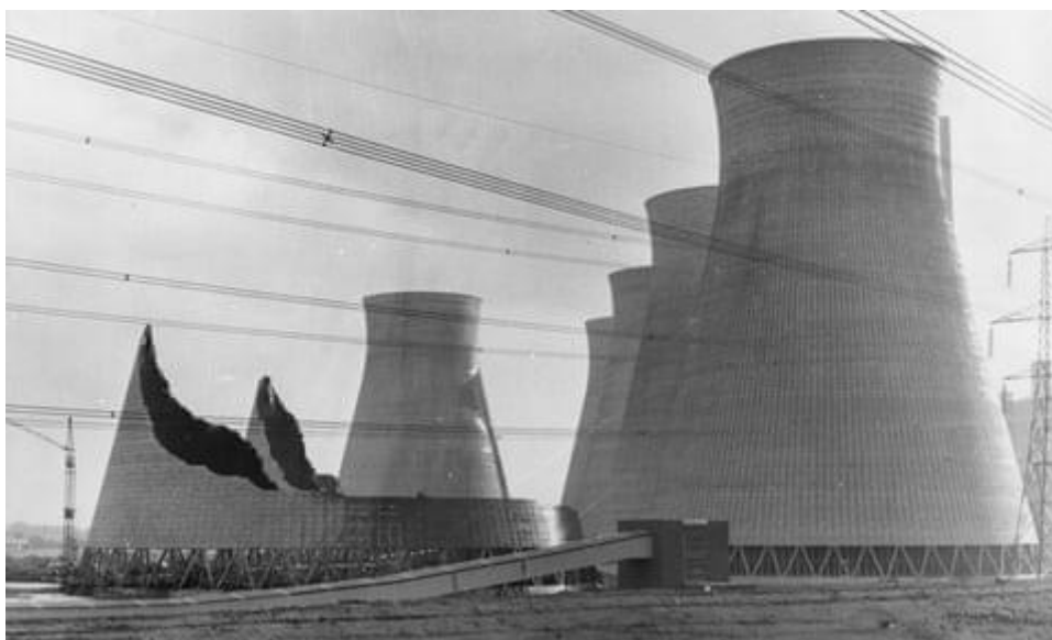
Рис. 1.7.2 Аварія градирень на електростанції Феррібридж в Великій Британії [45]
