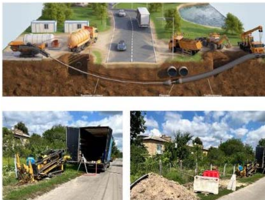
Рис. 4.17. Прокладання трубопроводу в населеному пункті методом ГНБ у населеному пункті, який досліджується
