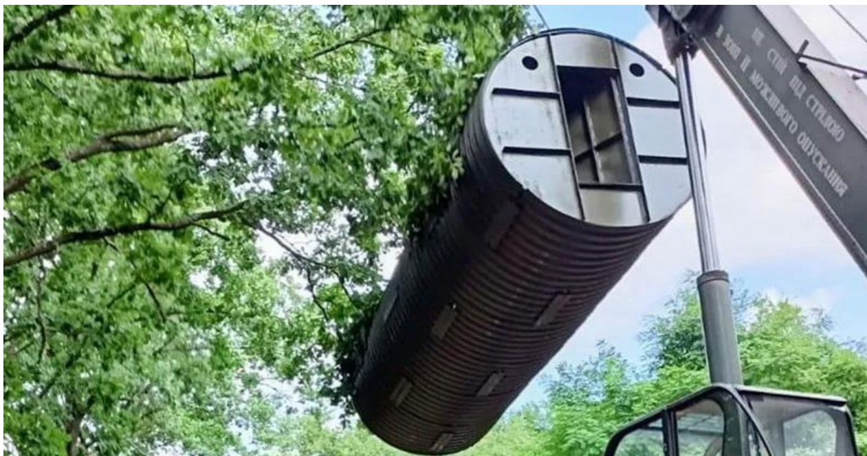
Рис.5.2. Загальний вигляд пофарбованого модульного укриття з гофрованої сталі.
