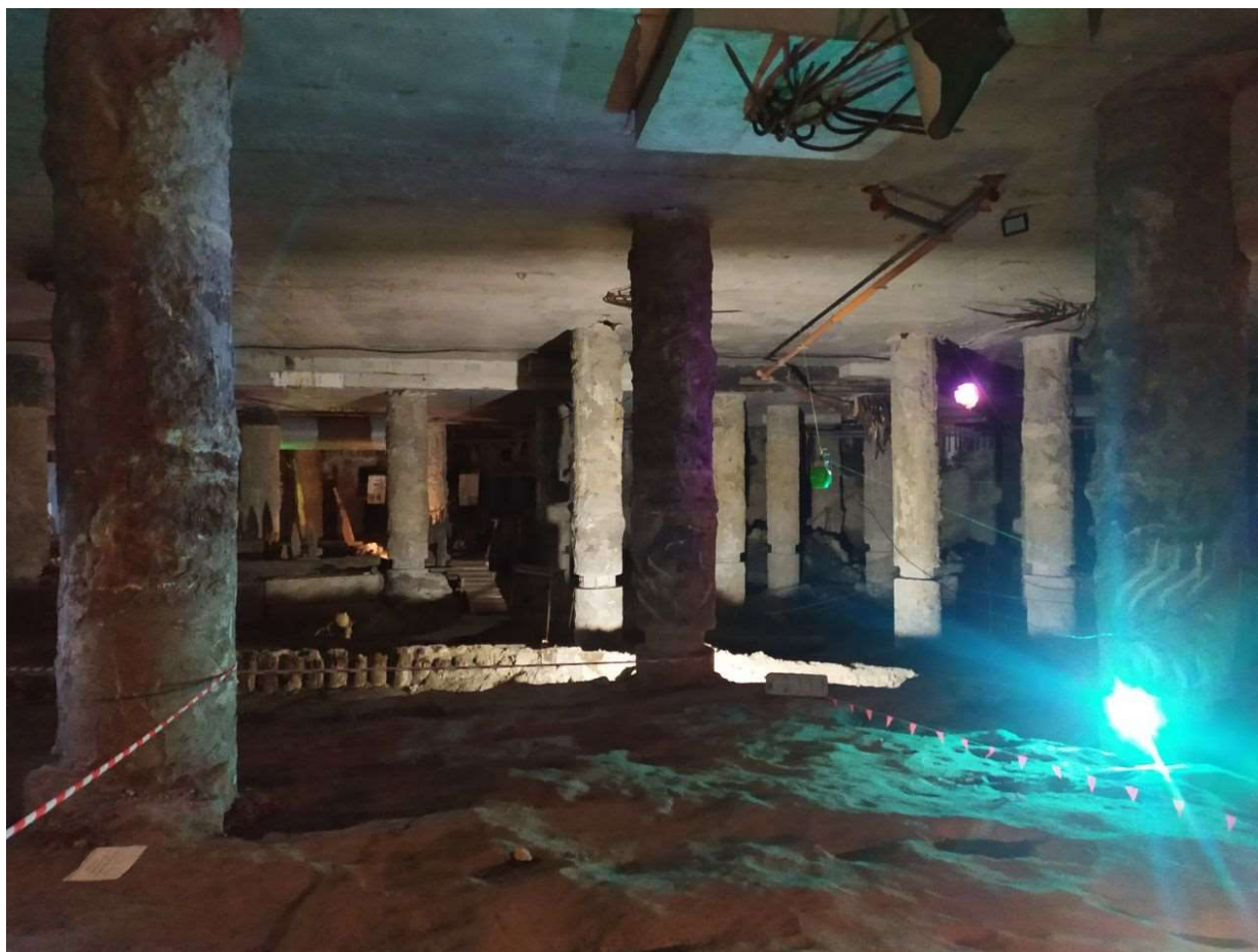
Рисунок 1.4 — Застосування технології «top-down» під час реконструкції Поштової площі
