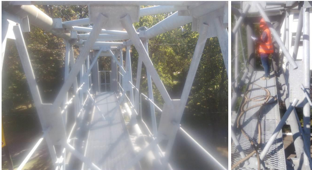
Рисунок 2.3. Загальний вид просторового блоку ферм із середини (фото зроблені під час обстеження)
