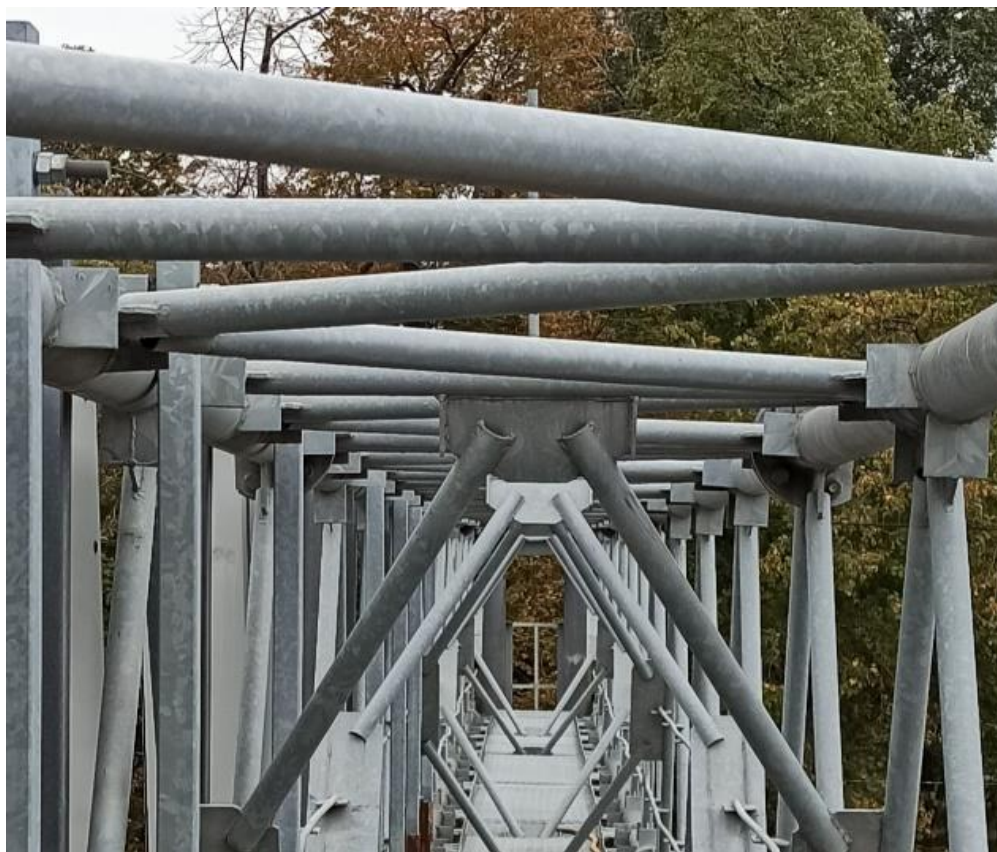
Рисунок 1.1. Сталеві оцинковані конструкції з труб, що застосовуються в автоматизованих системах регулювання дорожнього руху
