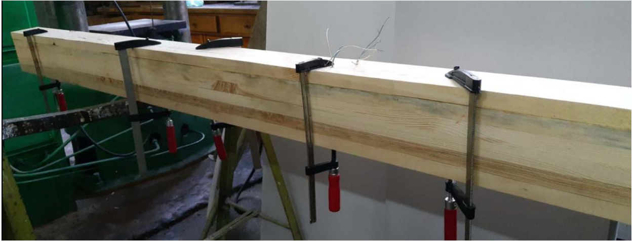
Рис. 4.2. Склеювання пакету дошок в конструкцію балки
