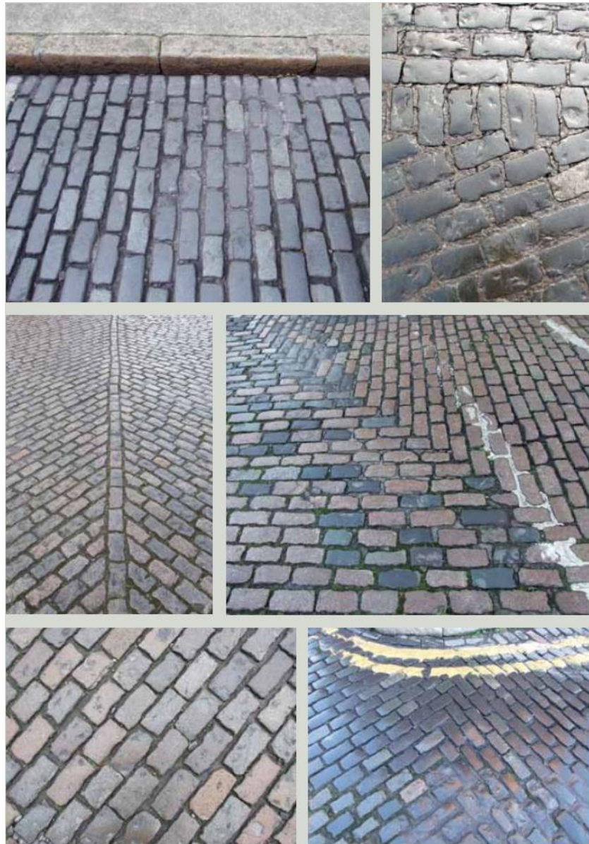
Рисунок 3.6 - Приклади традиційного мощення з натуральної кам'яної бруківки в історичних містах Європи: (Джерело: Paving: The Conservation of Historic Ground Surfaces (Ireland, 2015))
