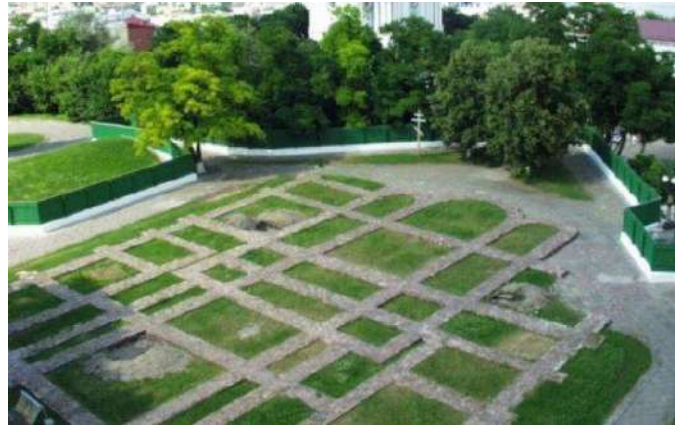
Рис. 3.19. Фундамент Десятинної церкви, м. Київ (Додаток Г)
