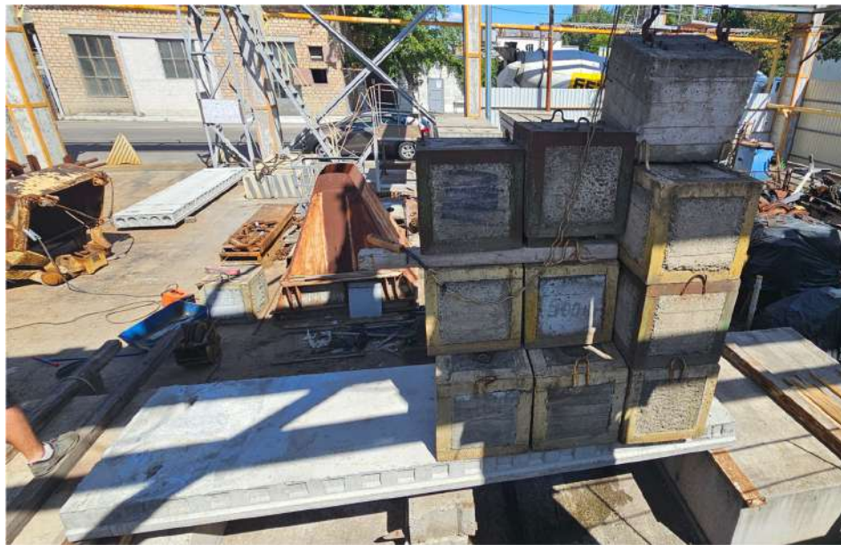
Рис. 3.34 – Процес навантаження плити
