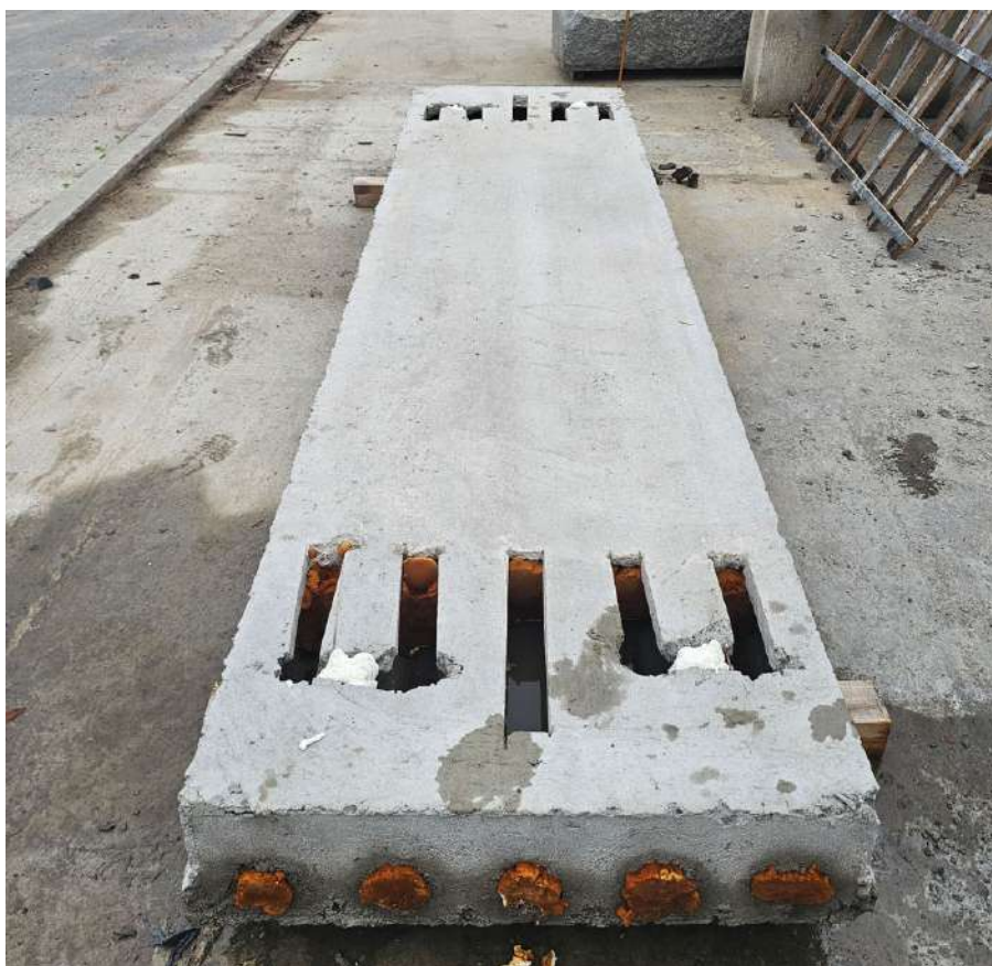
Рис. 3.32. Процес підготовки плити перед заповненням бетонною сумішшю
