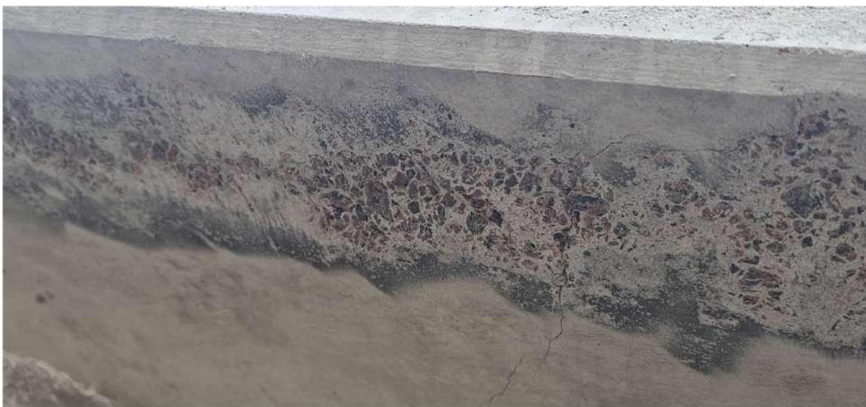
Рис. 3.25. Зовнішній вигляд підготовленої поверхні під приклеювання вуглецевого підсилення
