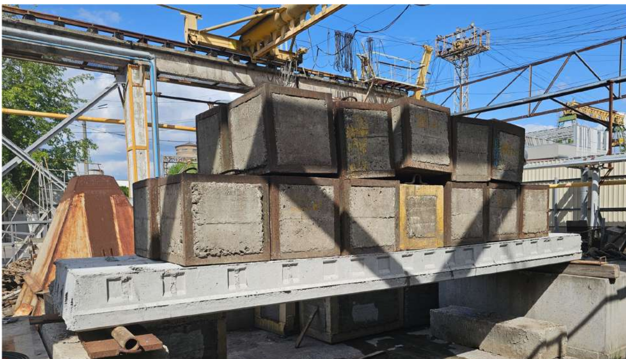
Рис. 3.24. Процес навантаження плити
