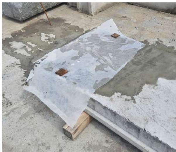
Рис. 3.33 – Зовнішній вигляд плити після бетонування:
