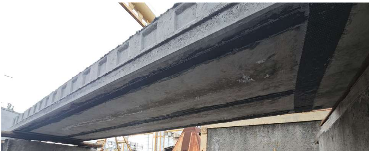
Рис. 3.28. Загальний вигляд плити, підсиленої вуглецевим армуванням
