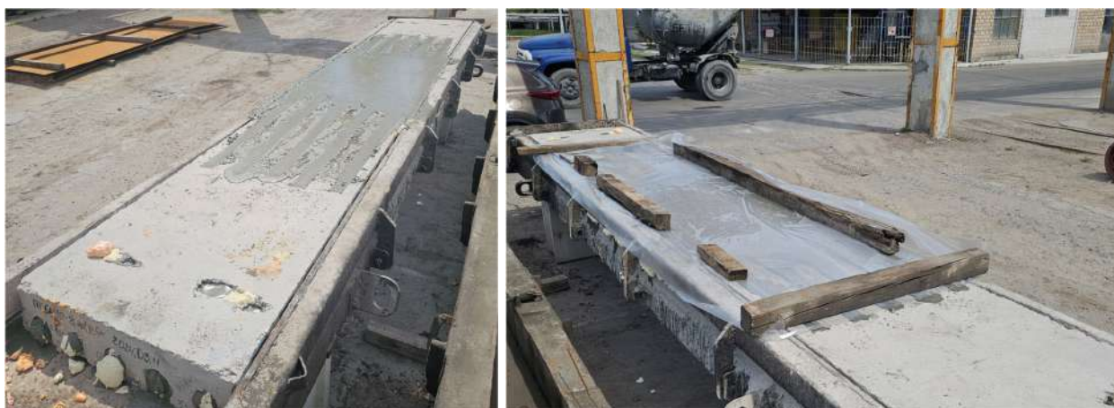
Рис. 3.19. Зовнішній вигляд плити після бетонування:
