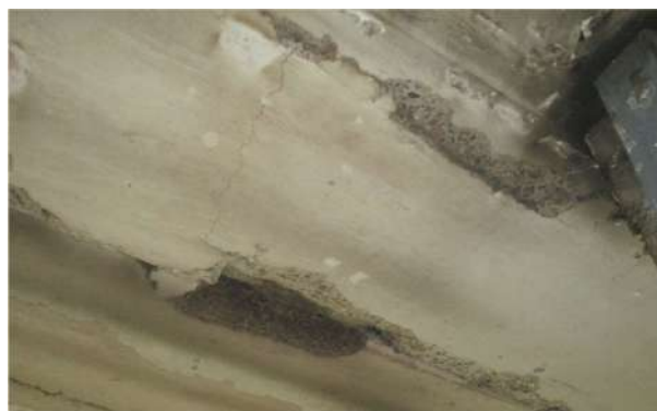
Рис. 1.3. Різновиди пошкоджень пустотних плит: а – пошкодження внаслідок дії високої температури/ вогню; б – пошкодження внаслідок дії понаднормових динамічних навантажень (вибух); в – пошкодження внаслідок дії атмосферних впливів (системні замокання); г – пошкодження внаслідок перевантаження плити; д – пошкодження тіла внаслідок механічних впливів
