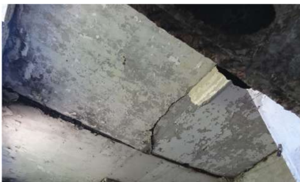
Рис. 1.3. Різновиди пошкоджень пустотних плит: а – пошкодження внаслідок дії високої температури/ вогню; б – пошкодження внаслідок дії понаднормових динамічних навантажень (вибух); в – пошкодження внаслідок дії атмосферних впливів (системні замокання); г – пошкодження внаслідок перевантаження плити; д – пошкодження тіла внаслідок механічних впливів
