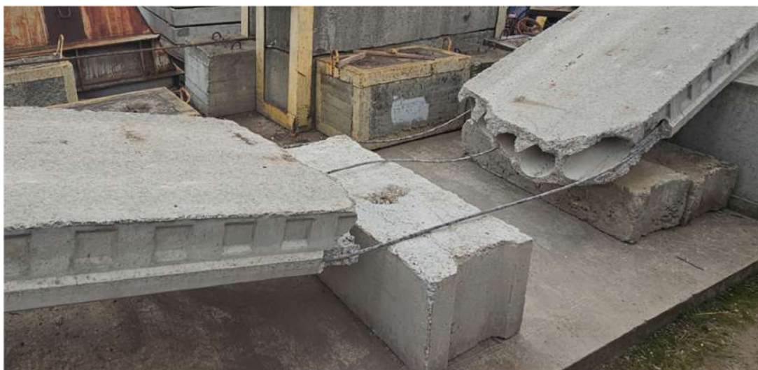
Рис. 3.16 – Зовнішній вигляд плити після очищення від зруйнованого матеріалу
