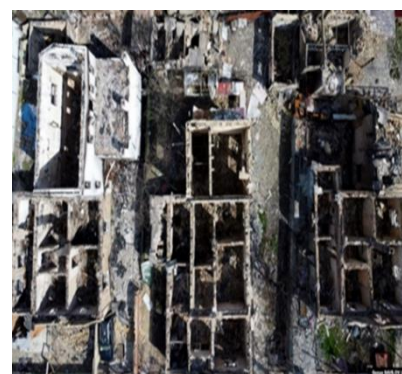
в) зруйнована частина житлового фонду
