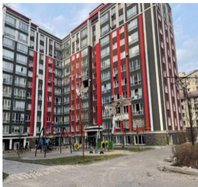
а) частково пошкоджений будинки
