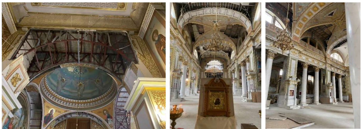
Рисунок 23 . Пошкоджений інтер'єр собору. Фото авт., м. Одеса, 2025
