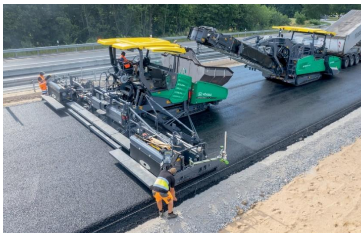
Рис. 1.11. Система компактного укладання асфальту
