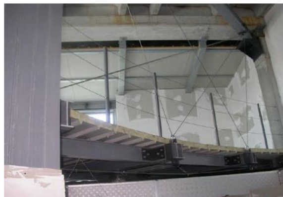
Рис.1.52. Допоміжний поверх, Верона, Італія (2006). Подвійна рама з GFRP-профілями та сталевими тросами, настил зі склопластикових двотаврових профілів
