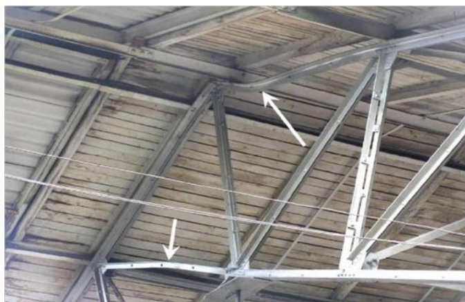
Рис. 4.9. Прогини окремих елементів решітки у площині ферми досягають 150 мм. Цех № 24 ВАТ «Донецькгірмаш» [56]
