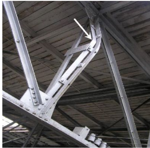
Рис. 1.32. Стійки ферми, перевантажені снігом, підсилені додатковим елементом. Цех № 24 ВАТ «Донецькгірмаш» [56]
