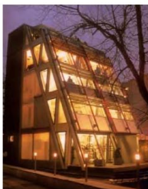
Рис.1.51. Euycatcher, Базель, Швейцарія, 1999 р. 5-поверхова будівля зі склопластиковими балками та колонами, з'єднання — болтові.
