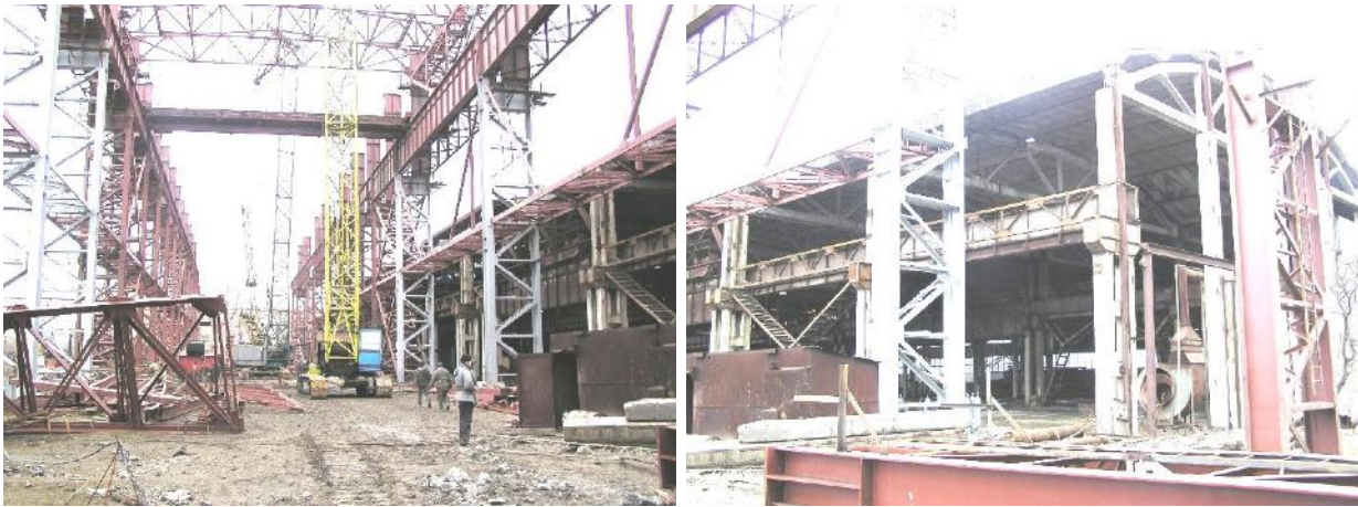
Рис. 1.12. Прибудова нових об'ємів будівлі: печний проліт на підприємстві ООО «Електросталь» у місті Курахово [57]
