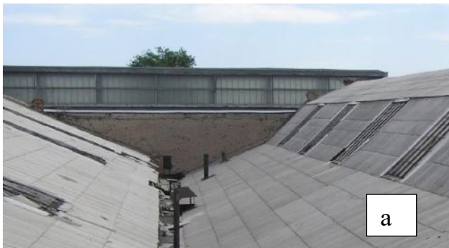
Рис. 1.1. Обвалення покриття у Запоріжжі від навантаження снігом взимку 1986-87 рр.
