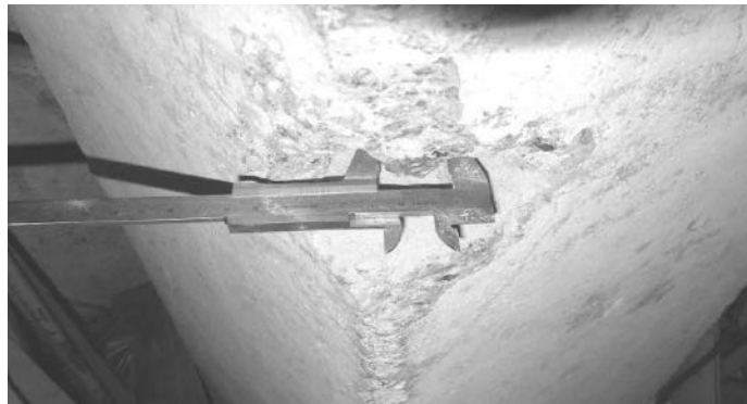
Рис. 3.12. Визначення діаметра робочої арматури колони. ТОВ «Електросталь», м. Курахово Донецької області
