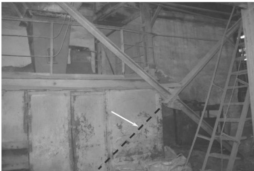
Рис. 4.3. Виріз частини хрестового зв'язку (для устаткування). ВАТ «Донецькгірмаш» [56]
