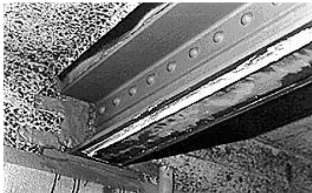
Рис.1.44. Підсилення існуючих балок двома пластинами з вуглецевого волокна. Транспортний міст Слаттокса, Англія [102].
