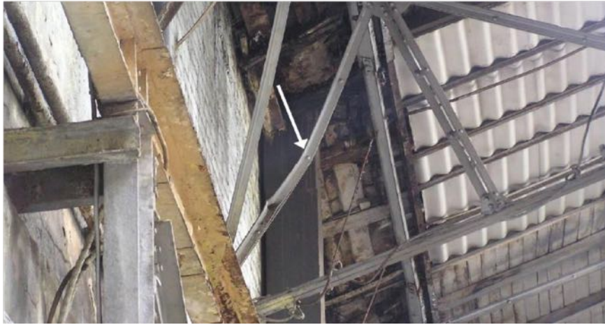
Рис. 4.12. Втрата стійкості опорного розкосу в результаті перевантаження покриття снігом. ВАТ «Донецькгірмаш» [56]
