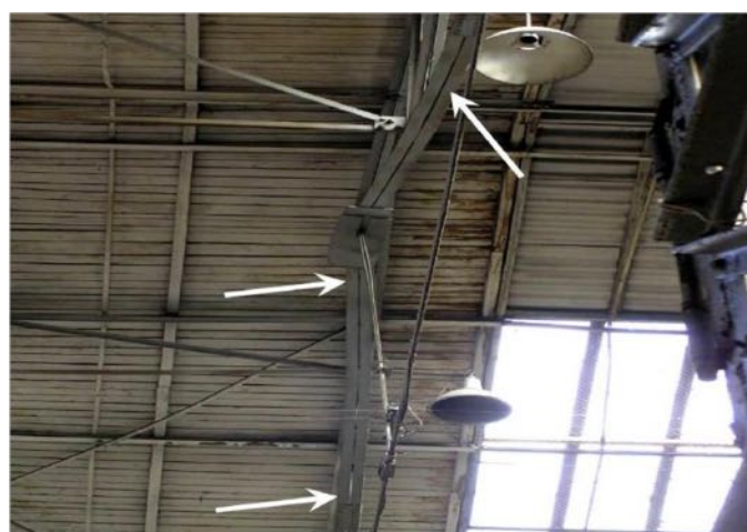
Рис. 4.10. Вигин до 400 мм із площини нижнього пояса ферми. ВАТ «Донецькгірмаш» [56]
