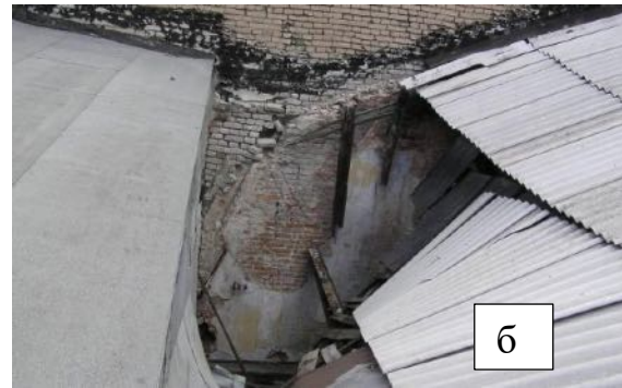
Рис. 1.1. Обвалення покриття у Запоріжжі від навантаження снігом взимку 1986-87 рр.
