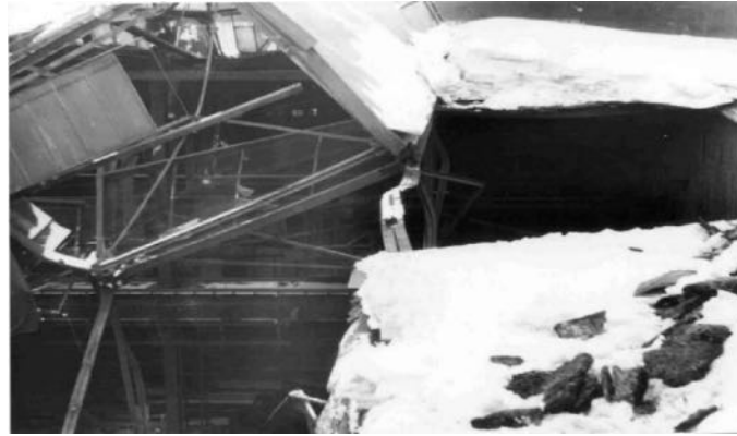
Рис. 1.1. Обвалення покриття у Запоріжжі від навантаження снігом взимку 1986-87 рр.
