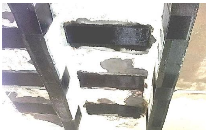
Рис. 1.47. Підсилення залізобетонних монолітних балок і плити зовнішнім армуванням композитним матеріалом на основі вуглецевих волокон
