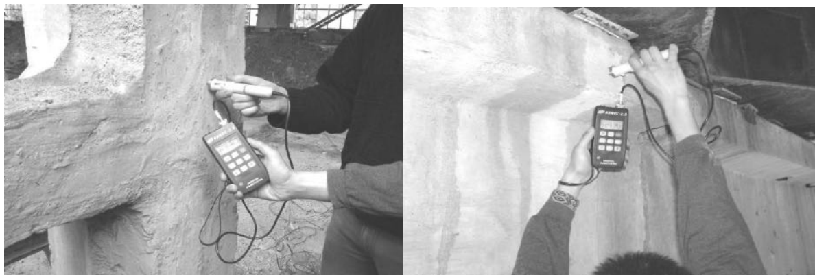
Рис. 3.11. Визначення міцності бетону в колоні та в підкрановій балці за допомогою вимірника міцності бетону ударно-імпульсного типу ОНИКС-2.5.
