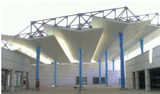
Рис.1.49. Суд Пескари, Пескара, Італія, 2006 р. Дах двотаврових склопластикових профілів (пултрузія) та сендвіч-панелей на FRP-основі з пінополіуретаном.
