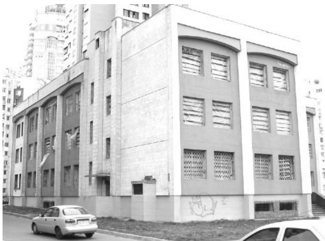
Рис. 1.5 Будівля каркасна залізобетонна під реконструкцію
