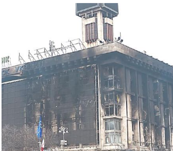
Рис. 1.9 Вигляд будинку профспілок після пожежі
