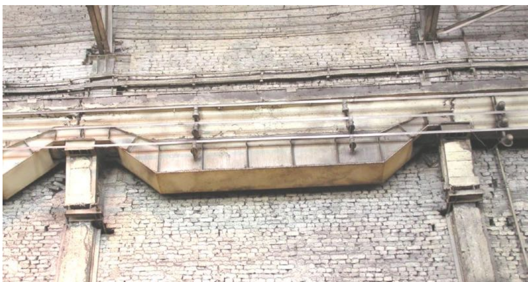
Рис. 1.25. Підсилення залізобетонної підкранової балки підведенням металевих коробчастих елементів. ВАТ «Донецькгірмаш» [56]
