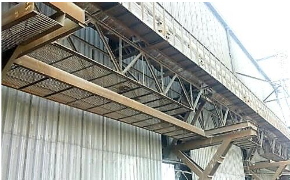
Рис. 1.26. Підсилення труби газоходу сталеплавильного цеху ТОВ «Електросталь» через корозію металу й утворення тріщин методом підведення несучих ферм під конструкцію труби [56]
