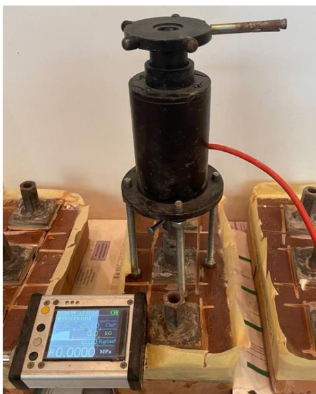
Рис. 3.7. Процес вимірювання міцності зчеплення ремонтних матеріалів з основою за допомогою адгезіометра
