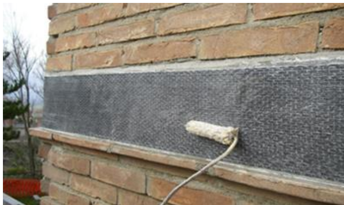
Рис. 1.8. Влаштування вуглецевої стрічки MapeWrap C UNI-AX 300 з нанесенням просочувального шару MapeWrap 31 [54]
