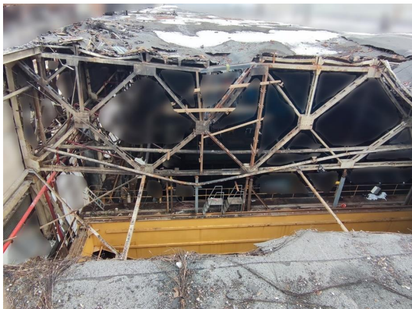
Рисунок 4.14 Реалізація першочергових протиаварійних заходів з піддомкрачуванням ферми за допомогою домкратів
