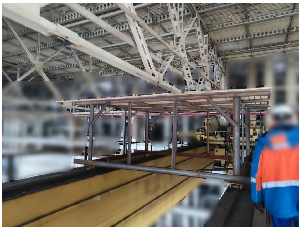
Рисунок 4.18 Реалізований варіант влаштування тимчасової монтажно́ї платформи (варіант ПВР)
