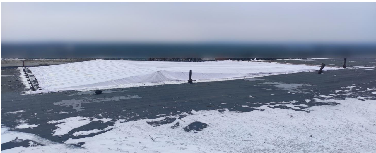
Рисунок 4.16 Влаштування тимчасового ізоляційного тенту над отвором в покритті
