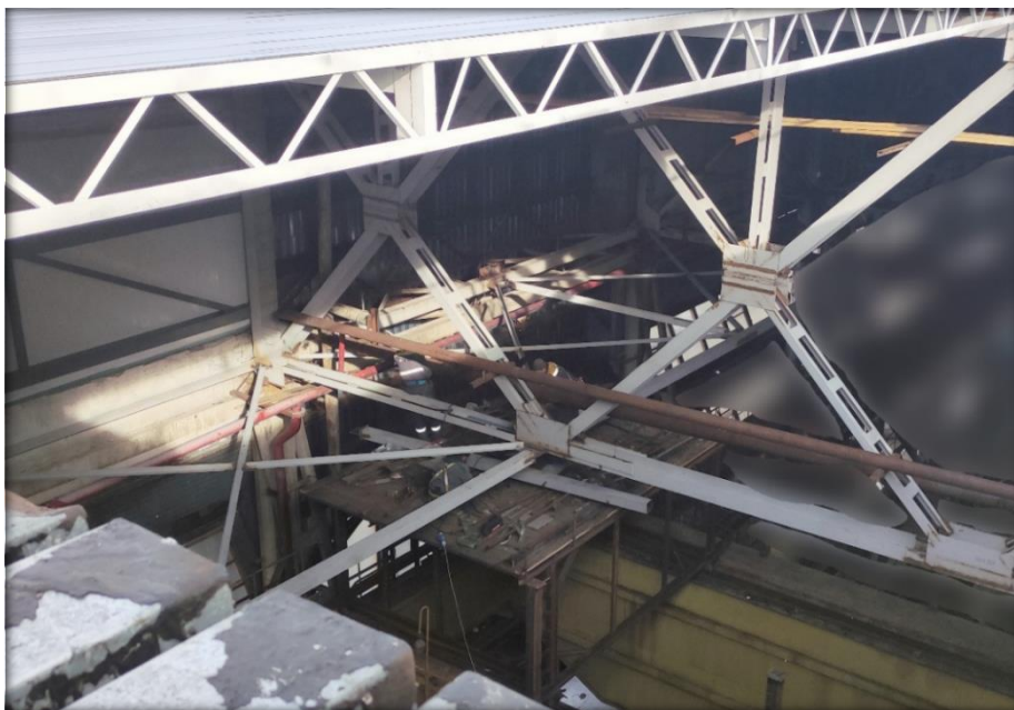
Рисунок 4.19 Виконання робіт по відновленню ферми з монтажної платформи
